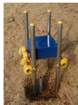
地盤沈下観測使用例
